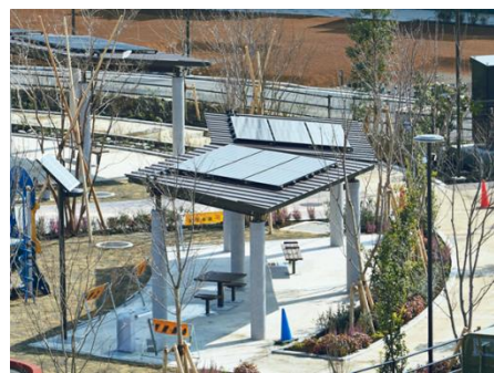
⑩太陽光発電付きのパーゴラ。(災害時はシートで囲み防災小屋)
