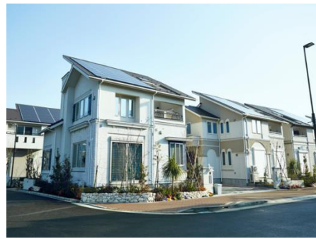
⑦電柱の地中化、全戸ソーラ付。地盤も1.5m底上げし津浪対応。
