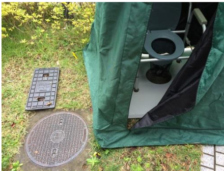
⑪マンホールトイレ(テントを被せれば災害用トイレとして使用可能)
